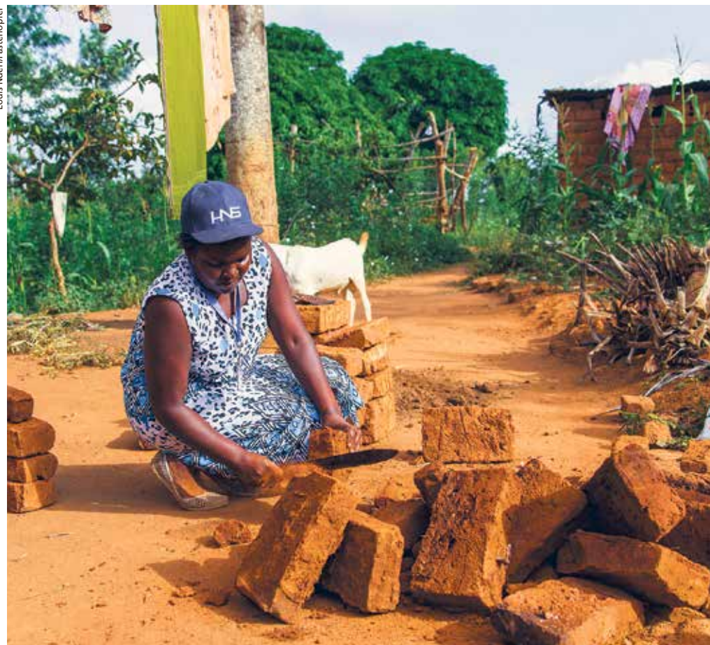
Ein grosses Anliegen des Projektes ist, dass Frauen und die Akzeptanz von Frauen als Konstrukteurinnen gefördert werden. Sie bilden mittlerweile fast die Hälfte aller Fachkräfte.
