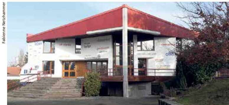
Wer das Pfarreizentrum Dreikönig in Füllinsdorf betrachtet, wird keinen Kirchturm und keine Glocken finden, aber dafür ein Kreuz – integriert in die Architektur, als tragenden Bestandteil des Baus.
