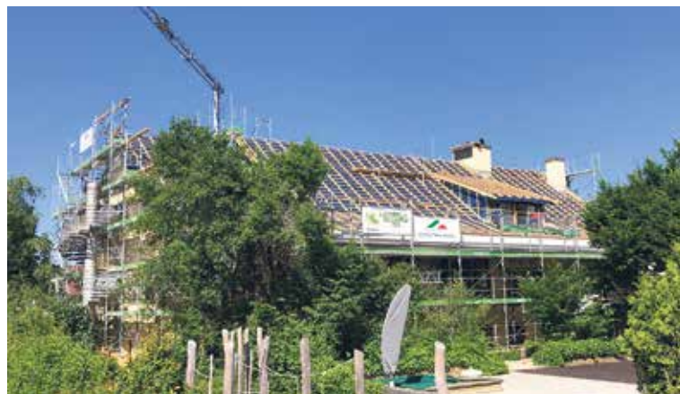
Freuen Sie sich. Das Pfarrzentrum erstrahlt demnächst in neuem Glanz. Am 22. August ist «Tag der offenen Tür» im neu renovierten Schallen mit einem angepassten Corona-Schutzkonzept.
