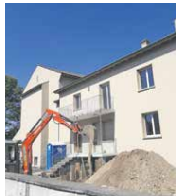
Umbau altes Pfarrhaus.
