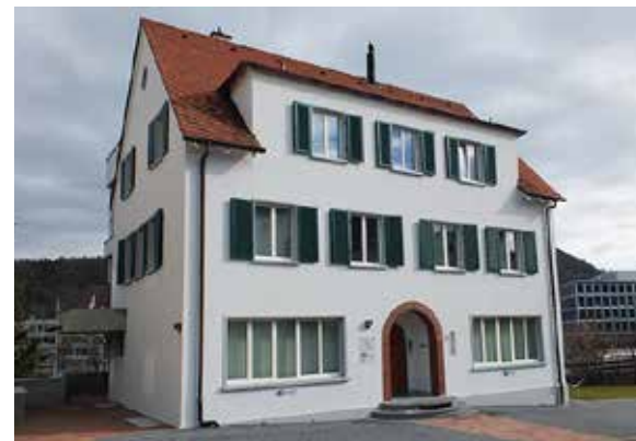
Das Pastorale Zentrum befindet sich in Liestal an der Munzachstrasse 2 im 2. Obergeschoss.
