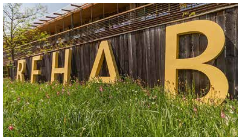
Fassade des Klinikgebäudes der Rehab Basel.
