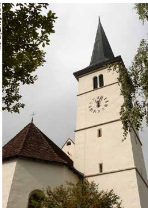
Blick auf die frisch sanierte Aussenhülle von St. Stephan – noch ohne Kreuz und Kugel auf dem Turm.
