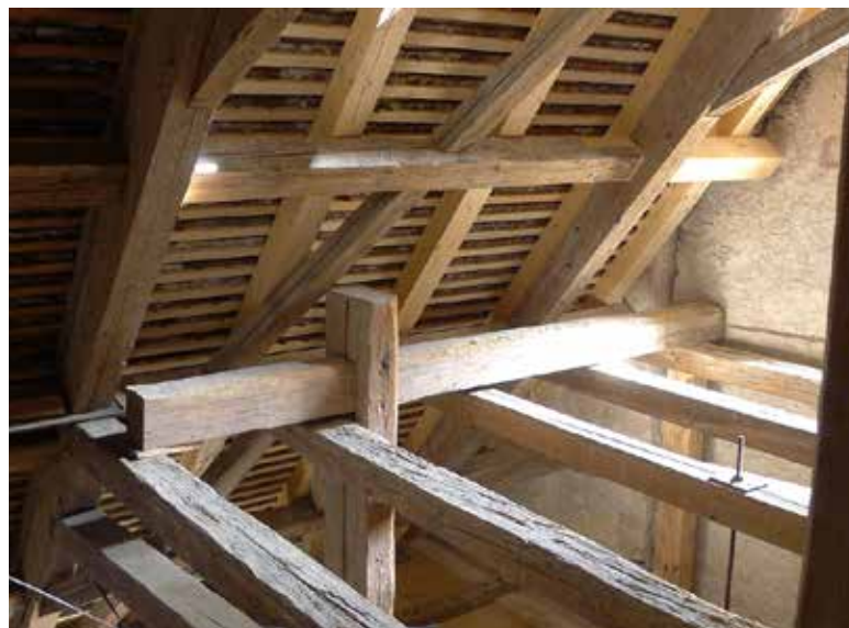
Alt und neu im Dachstuhl: Noch immer machen 400 Jahre alte Balken den wesentlichen Teil der Dachkonstruktion aus.
