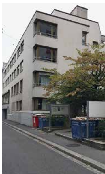
Die Umbauarbeiten sollen im November abgeschlossen sein.
