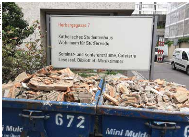
Das Katholische Studentenhaus an der Herbergsgasse präsentiert sich derzeit als Baustelle.
